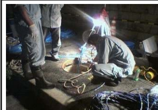
下水管渠入口周辺
