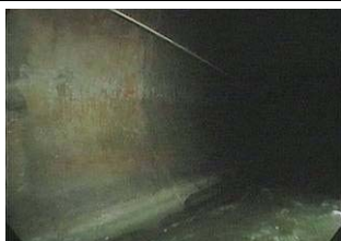
管渠内の様子
