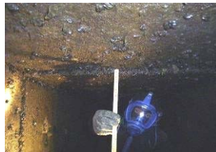
函内変状箇所調査
