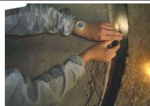
管内空洞化調査
