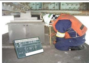
橋梁耐震調査
