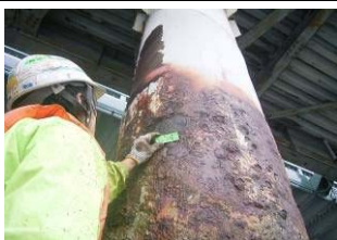
パイル・橋脚健全度調査
