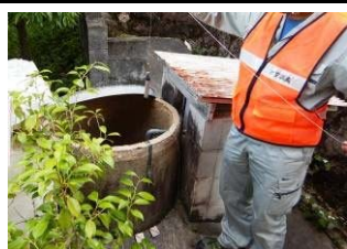
水位計の設置
