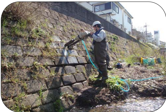
〈河川護岸〉 空洞化調査
