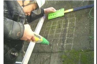
圧縮強度試験
