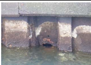
鋼材目視調査
