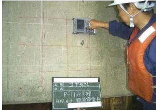
鉄筋レーダー探査
