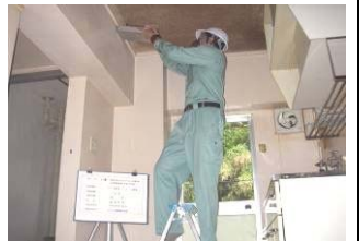
アスベスト調査
